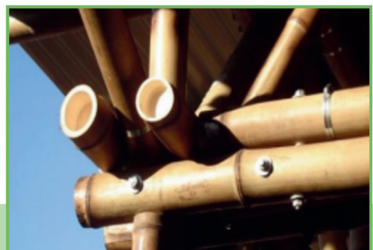
Jonction avec boulon et tige filetée
