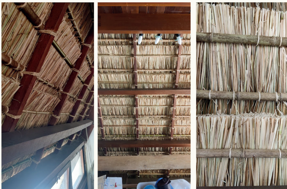
Couverture chaume de vétiver vu de l'intérieur, conception ouverte. Crédit : ent. Paille en toit
