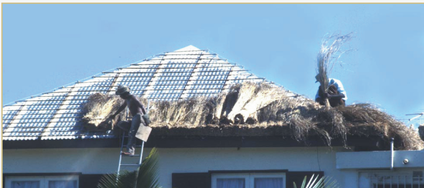
Pose d'une toiture vétiver sur toiture en tôle métallique. Crédit : CAUE réunion
